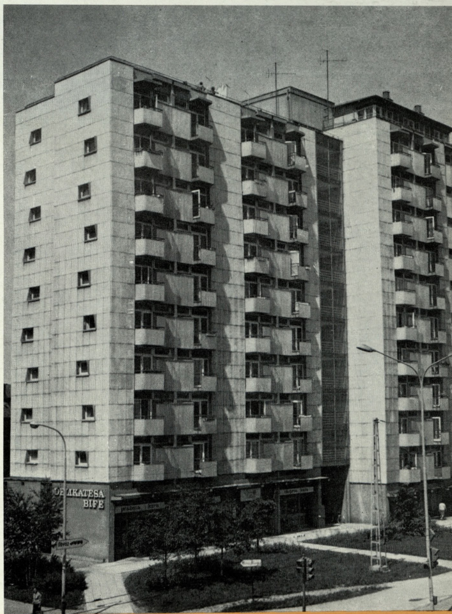
SGP STAVBENIK, gradbeno vodstvo Ljubljana: Garsonierska stolpnica Na Jami v Ljubljani
