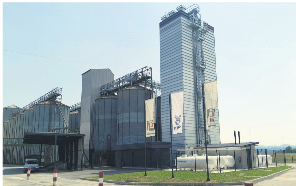
Foto: arhiv PP Nova sušilnica v Dražencih, kjer bodo tudi letos prevzemali koruzo z do 35 % vlage, omogoča prevzem večjih količin žit v krajšem času, kar pomeni manj izgube časa za razkladanje.
