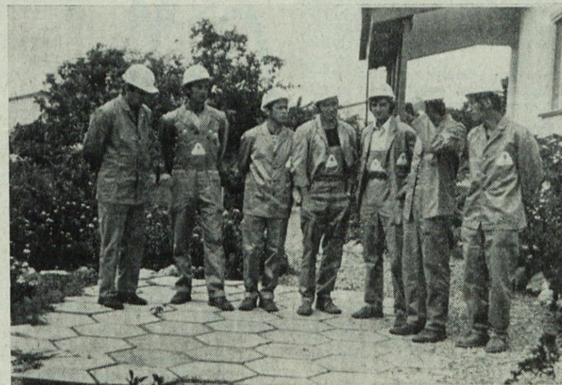
Skupina litostrojskih monterjev, ki delajo na gradbišču HE Kamburu
