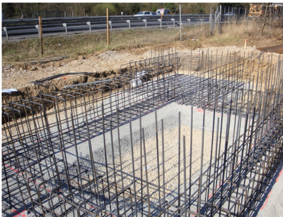
Slika 9 • Priprava armiranobetonskih temeljev ob avtocesti.
