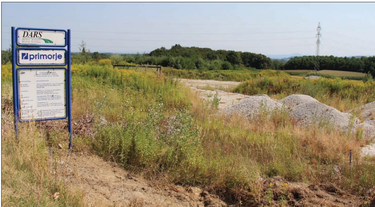
Dars je pred leti že začel odkupovati zemljišča in opravljati prva gradbena dela. Danes je gradbišče prerasla trava, pa tudi gradbenega podjetja Primorje, ki naj bi cesto gradilo, ni več.
