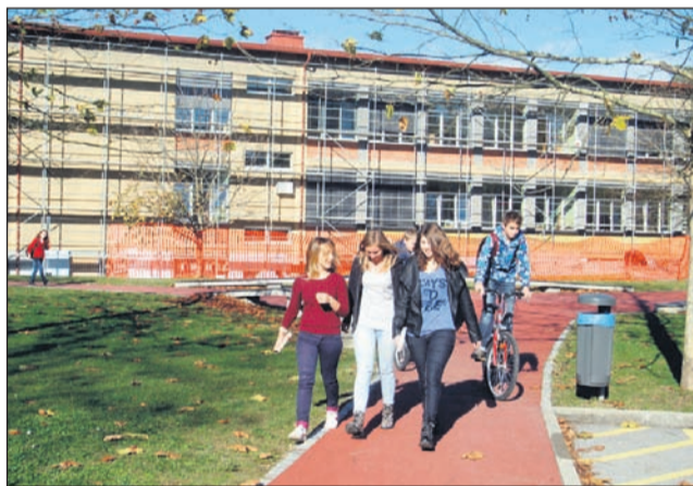
Osnovna šola Borisa Kidriča v Kidričevem je že odeta v gradbene odre, saj so pričeli temeljito energetska sanacijo več kot pol stoletja starega poslopja.
