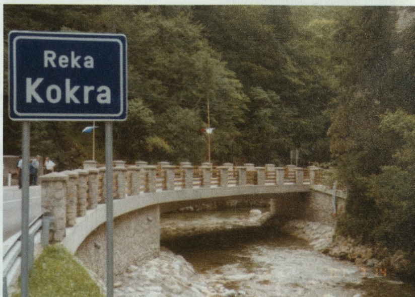
Slika 5.2: Taborski most čez Kokro na cesti R1-210/1106; (Proj.: PPK Kranj, Izv. del: CMC Ce. - 2000; vrednost del: 170 mio SIT)
