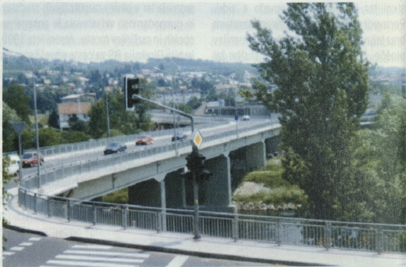
Slika 6.3: Most čez Savo in nadvoz nad železnico v Krškem na cesti R1-220/1334 (Izv. del: GP Gradis Lj. - 1999; vrednost del: 350 mio SIT)
