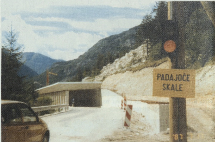
Slika 6.4: Galerija Berebica za zaščito ceste v Trenti na R1-206/1029 (Izv. del: Gradis NG Mb. - 2000; vrednost del: 500 mio SIT)
