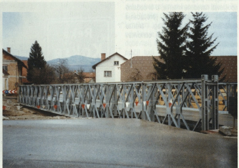
Slika 5.1: Montažni jekleni most MABEY-JOHNSON (COMPACT 200) služi za obvoz med gradnjo mostu na cesti G2-106/264
