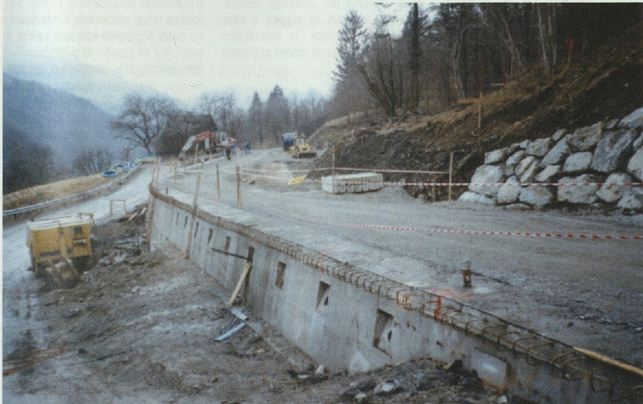
Slika 7.1: Pilotna stena pri sanaciji plazu Kneža na cesti R2-403/1072 (Izv. del: VGP Soča Ng. - 2000; vrednost del: 120 mio SIT)
