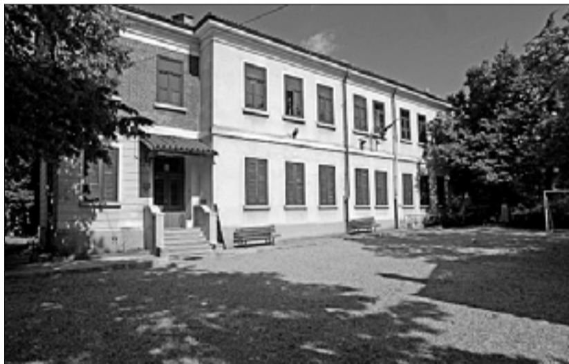
Poslopje osnovne šole Trubar v Bazovici je potrebno popravil
