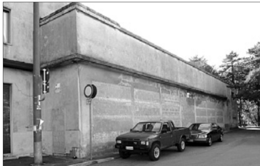
Poslopje bivše kinodvorane Belvedere na Opčinah
