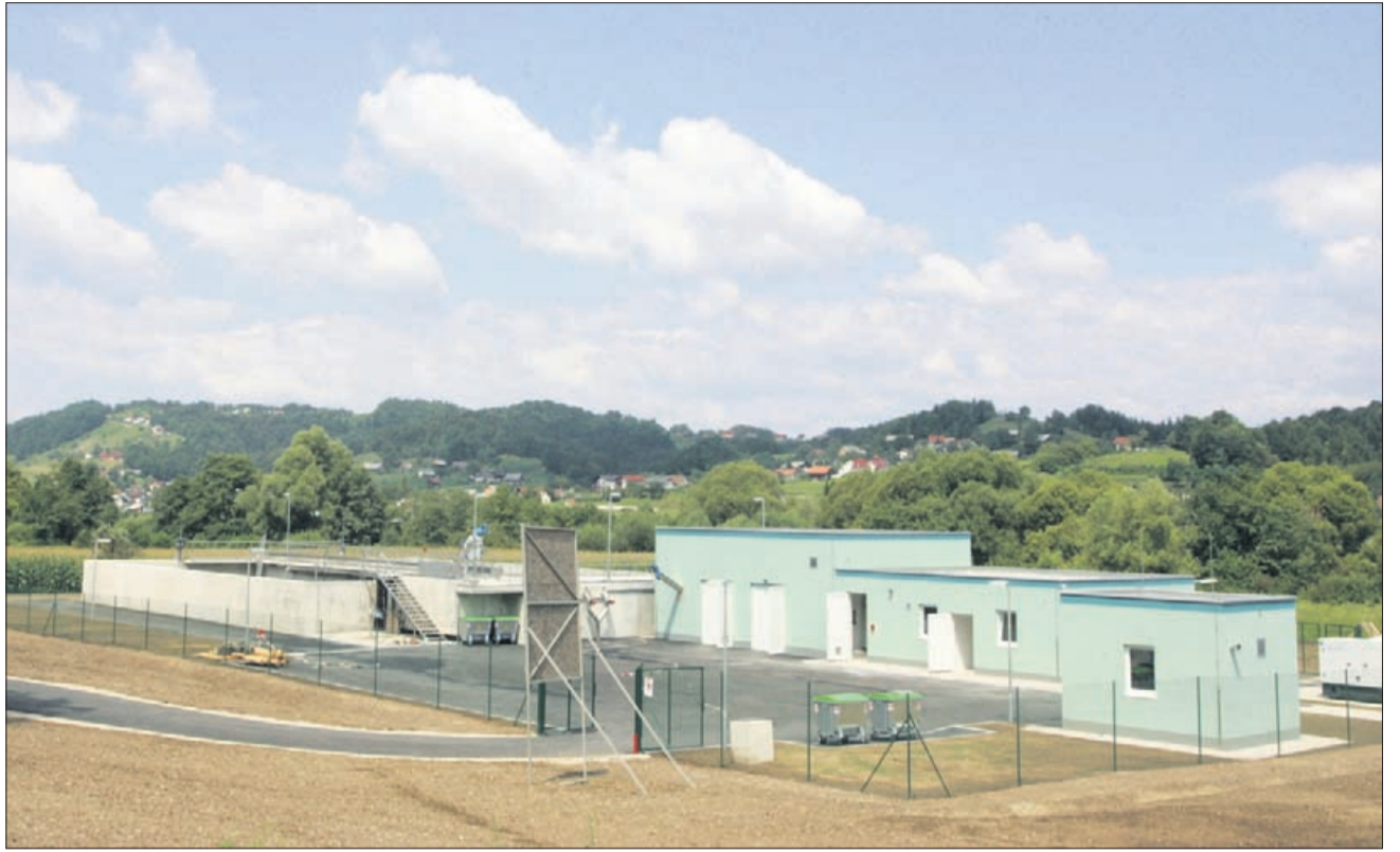
Čistilna naprava Šentjur
