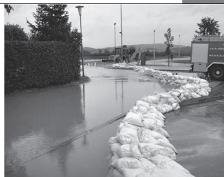
Gasilec je vodo ponoči uspelo odvrniti od Gasilskega centra Grosuplje s prekopi in nasipi z vrečami peska. (fotografirano 19. 9., ob 9.34).
