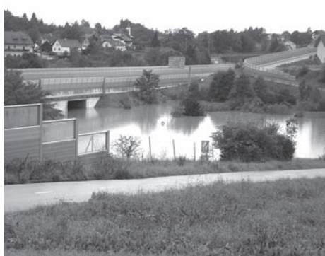
V nedeljo je bil ob 10.13 šmarnski avtocestni priključek približno 2,5 m pod vodo.
