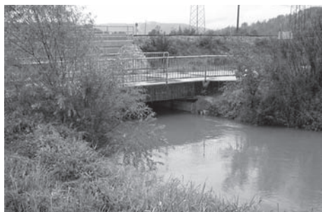
Dotok vode proti mostu na slivniški cesti in vzporedni železniški progi je bil 18. 9., ob 9:11, še vedno znosen in v soboto dopoldne še ni poplavljal čistilno napravo.
