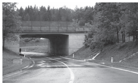
V nedeljo zjutraj je bil tudi avtocestni podvoz pri Hotelu & Casino Kongo pod vodo in je prav tako dopoldne voda že odtekla. (9.38).
