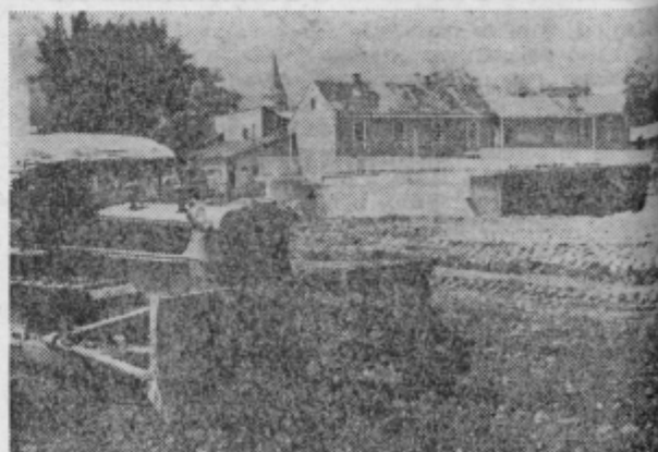
Izvajalci regulacijskih del hite z delom na vseh koncih. Medtem ko eni urejajo in poglobljajo korito Sušnja, druga skupina utrjuje nasip ob novem mostu preko Voglajne pred Toprom. Voglajna sicer še teče po starem koritu. Foto: J. Sever
