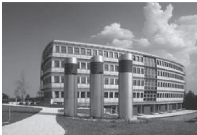
Slika 8: Energon – največja poslovna pasivna zgradba na svetu, Ulm, Nemčija. Figure 8: Energon – the biggest passive office building in the world, Ulm, Germany.
