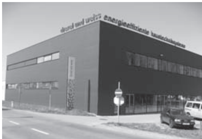
Slika 10: Industrijski objekt podjetja Drexel und Weiss, Wolfurt, Avstrija. Figure 10: Industrial facility of the Drexel & Weiss company, Wolfurt, Austria.
