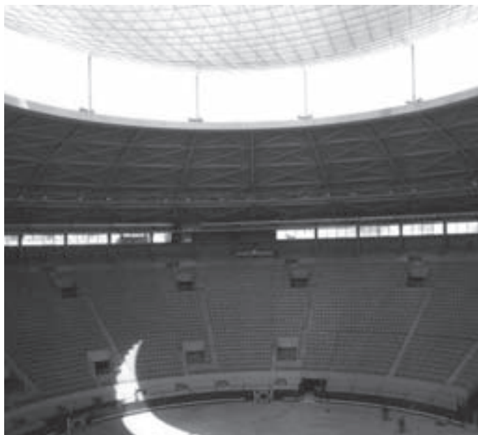
Slika 1: Osrednji del strehe arene za bikoborbe v Madridu se odpira in je pnevmatično napihnjena transparentna membrana, raztegnjena okoli jeklenega obroča. Membrana je narejena iz belega PVC – prevlečenega poliestra (PVC-coated polyester) in napihnjena z zrakom pod pritiskom 4 milibare. S prekrito površino 2000 m 2 je trenutno največja ponjava na svetu [Schlaich, 2003].
