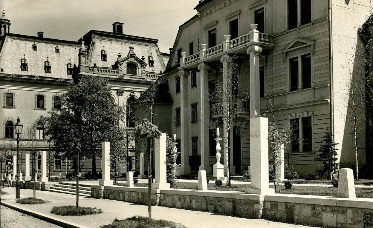
Slika 2: Stavba Glasbene matice Ljubljana, ok. 1932 (Zgodovinski arhiv Ljubljana)
