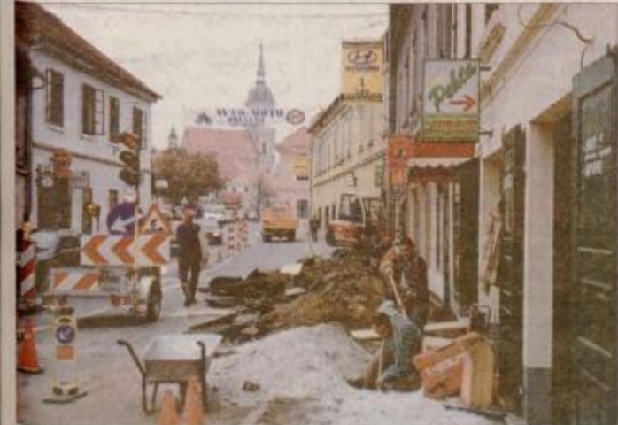
Delavci mariborskega Telekoma polagajo na bistriških ulicah nove telekomunikacijske kable. Foto: VT
