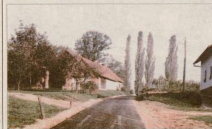
Posodobljene ceste, vodovod, kmalu še nova šola ...
