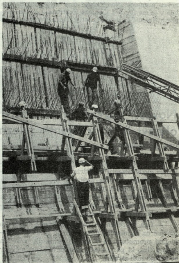
Sl. 2. Sidrani podporni zid v mehki hribini ob progi pri Hrastniku
