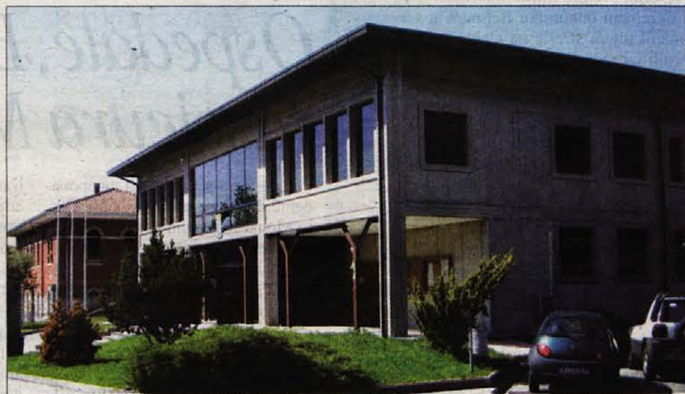
La sede municipale di Torreano
