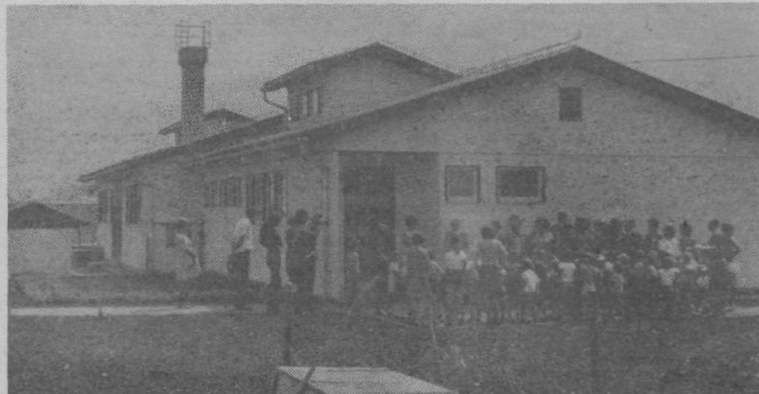
Na posnetku vidimo novo stavbo vzgojno-varstvenega zavoda v Zalogu tik pred otvoritvijo
