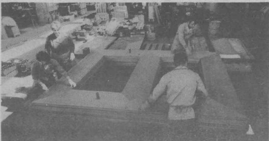
V Energoinvestu na Črnučah bodo letos za 30% presegl lanski fizični obseg proizvodnje. Na sliki: postopek zlaganja jedra transformatorja tip RT 31,5/31,5/21 MVA 110/36, 75/21 kV za Pristino. Jedro je napravljeno iz 11.400 kosov pločevine vrste hipersil m 4 (iz ovoza) debeline 0,3 milimetra in tehta 18.400 kilogramov.
