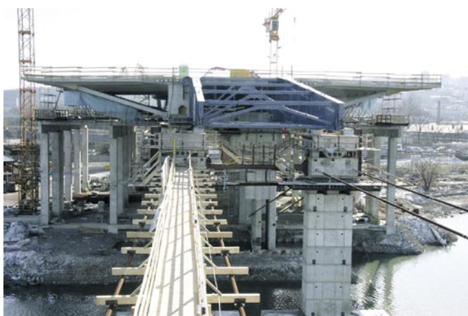
Voziščna konstrukcija izjemne širine 45 m na delavnici in začasnih podporah (feb 2010)
