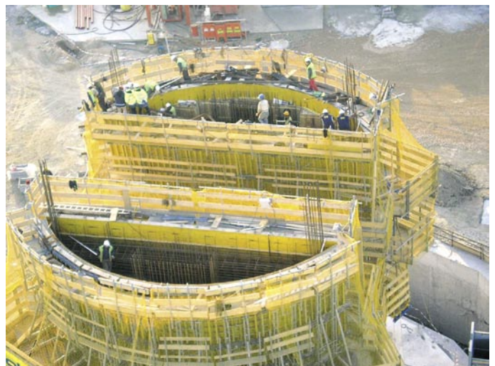
Pilon mostu je bil novembra 2009 zgrajen do nivoja prekladne konstrukcije v višino približno 20 m
