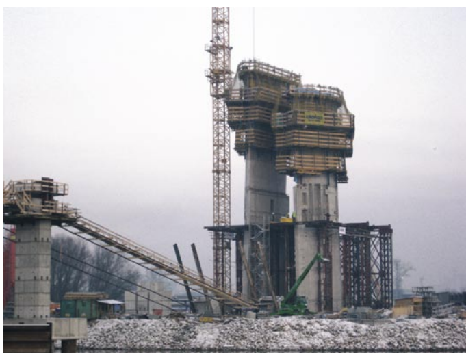
Gradnja pilona s pomičnim opažem (stanje februar 2010)
