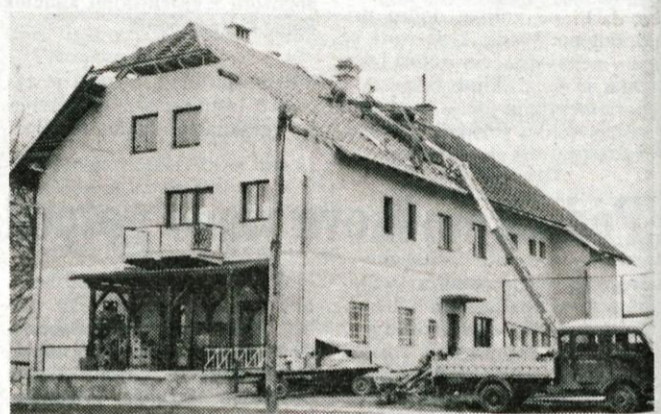
Po dolgotrajnem ugotavljanju in načrtovanju so se letos lotili tudi obnove Zadrúžnega doma.
