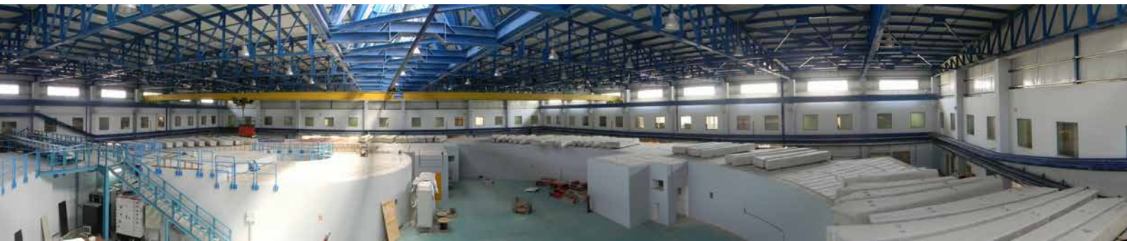
► Notranost SESAME: Pogled v eksperimentalno dvorano SESAME; v notranji krožni strukturi je mikrottron, ki priskrbi zdaj že delujočo prvo stopnjo pospeševanja ter predpospeševalnik sinhrotrona; v zunanji krožni strukturi bo novi glavni 2,5-GeV shranjevalni obroč. (Vir: SESAME)
