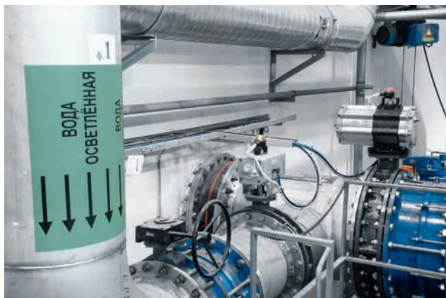
► Pnevmatični pogoni različnih velikosti zagotavljajo zanesljivo odpiranje in zapiranje ventilov za dovod vode in splakovanje pri čiščenju peščenih filtrov. (Foto: Festo AG & Co. KG)
