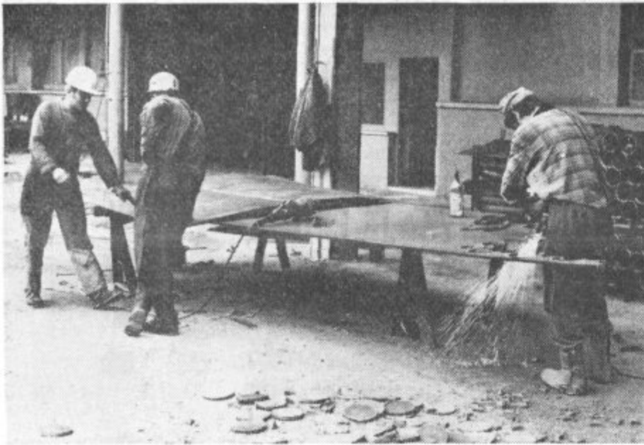
Delo v elektrostrojnem obratu
