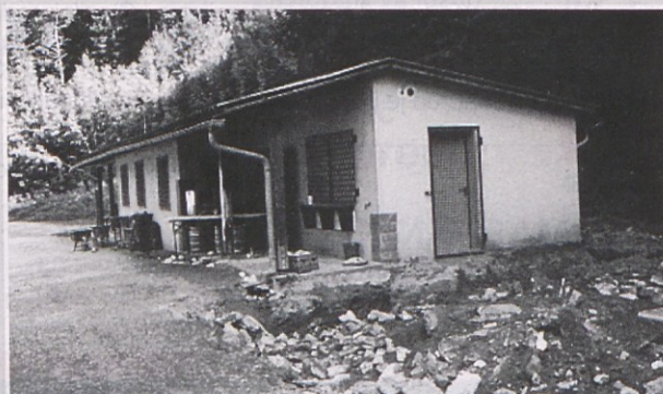
Prezidava in obnova stare kabine v Železni Kapli teče s polno paro, saj bi naj bila gotova že vigredi prihodnjega leta.
