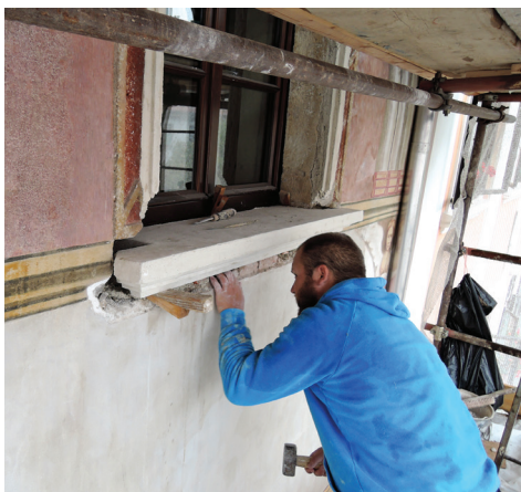
Zamenjava najbolj poškodovane police z novo. (foto: Saša Stržinar, september 2015)
