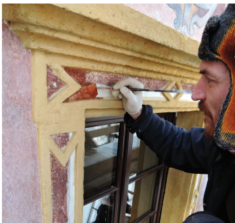
Retuša kamnitih elementov na fasadi rotovža. (foto: Saša Stržinar, september 2015)
