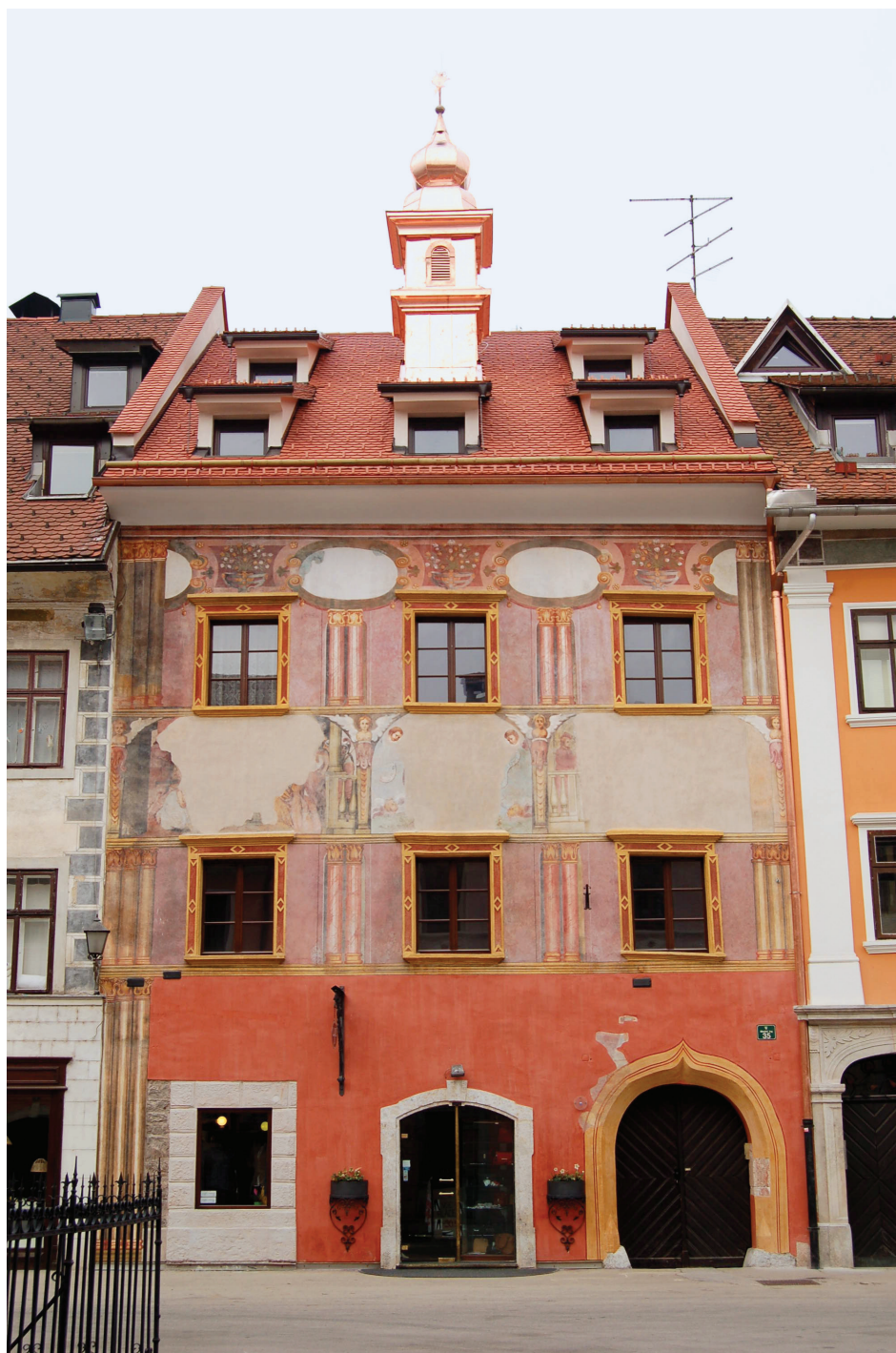
Rotovž po dokončanju del na fasadi. (foto: Mateja Kavčič, marec 2016)
