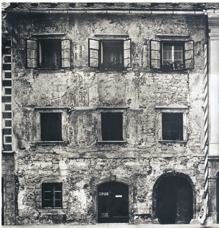
Stanje fasade po odkrivanju poslikav leta 1974, Inštitut za geodezijo in fotogrametrijo. (vir: arhiv ZVKDS Restavratorski center)
