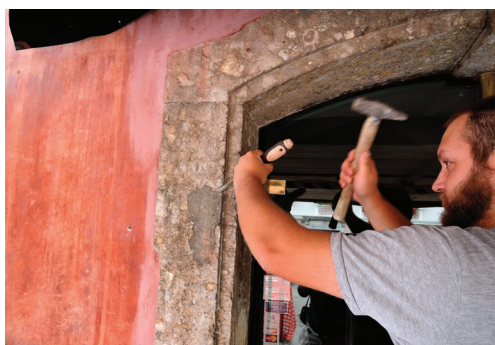
Odstranjevanje neprimernih cementnih zapolnitev s kamnitih portalov. (foto: Saša Stržinar, september 2015)
