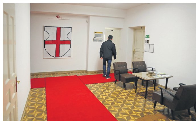
Preproge so namestili predvsem zaradi poškodb keramike in nevarnosti zdrsa.
