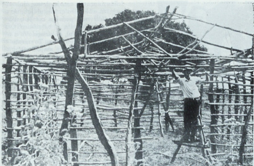
Salezijanski brat Štefan Burja pri sestavljanju ogrodja za zidavo preproste vaške cerkvice; vse brez vsakega cementa!
