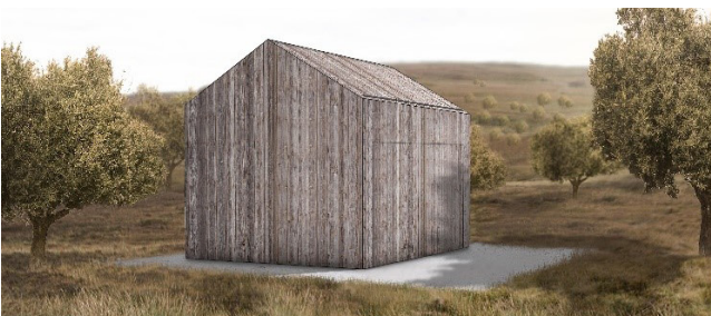
Slika 4: Kažeta je namenjena shrambi orodja in kmetijske mehanizacije ter osnovnim higienskim potrebam - enostaven kvader z dvokapno streho, kateremu se večji del južne fasade odpre, ter tako ustvari potrebno senco ob poletnih vročih dneh ali zavetje pred dežjem (avtorja: Žiga Adamčič, Ren Kaligarič; predmet: Ekološka načela gradnje).
