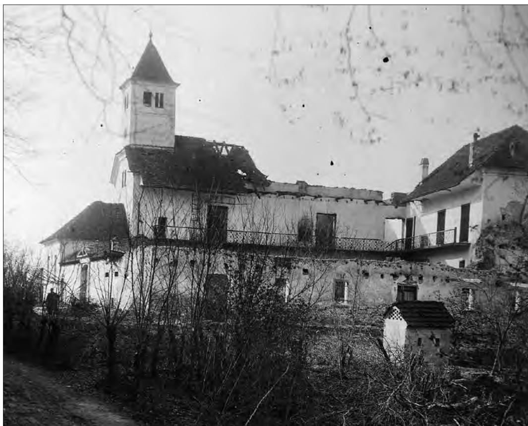
Pogled na v požaru poškodovani grad Branek z jugovzhodne strani januarja 1926 (foto: France Stele, INDOK).
