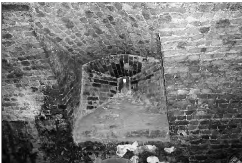
Značilno oblikovana ključasta strelna lina iz prve polovice 16. stoletja na severozahodnem delu zunanje severovzhodne stene v kleti obranjenega osrednjega trakta gradu Branek (foto: Klavdija Vnuk, 2015).
