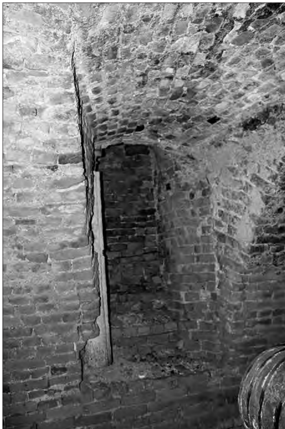
Prvotni vhod v klet gradu Braneč, ki so ga v 18. stoletju z zunanje strani zazidali, in pogled na del ometane obočne konstrukcije v severozahodnem prostoru pritličja nekdanjega osrednjega trakta gradu Braneč (foto: Klavdija Vnuk, 2015).
