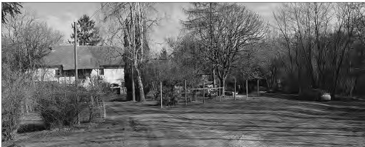
Pogled na ostanke gradu Branek z glavno dostopno potjo po obsežnih rušitvah v 20. stoletju (foto: Igor Sapač, 2022).
