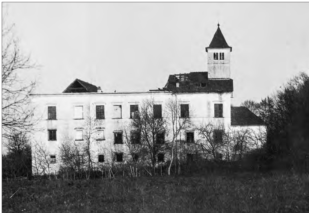
Pogled na v požaru poškodovani grad Branek s severozahodne strani januarja 1926 (foto: France Stele, INDOK).
