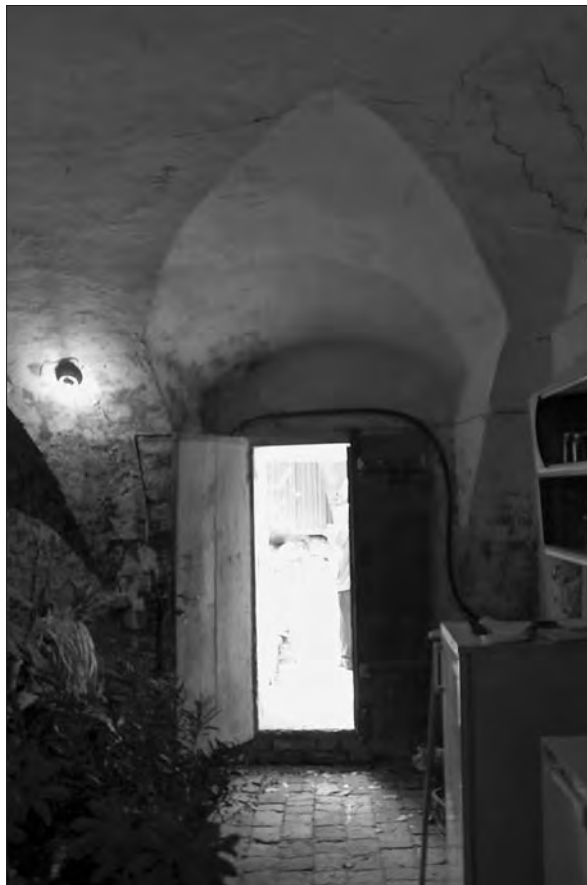
Prvotni vhod v klet gradu Braneč, ki so ga v 18. stoletju z zunanje strani zazidali, in pogled na del ometane obočne konstrukcije v severozahodnem prostoru pritličja nekdanjega osrednjega trakta gradu Braneč (foto: Klavdija Vnuk, 2015).
