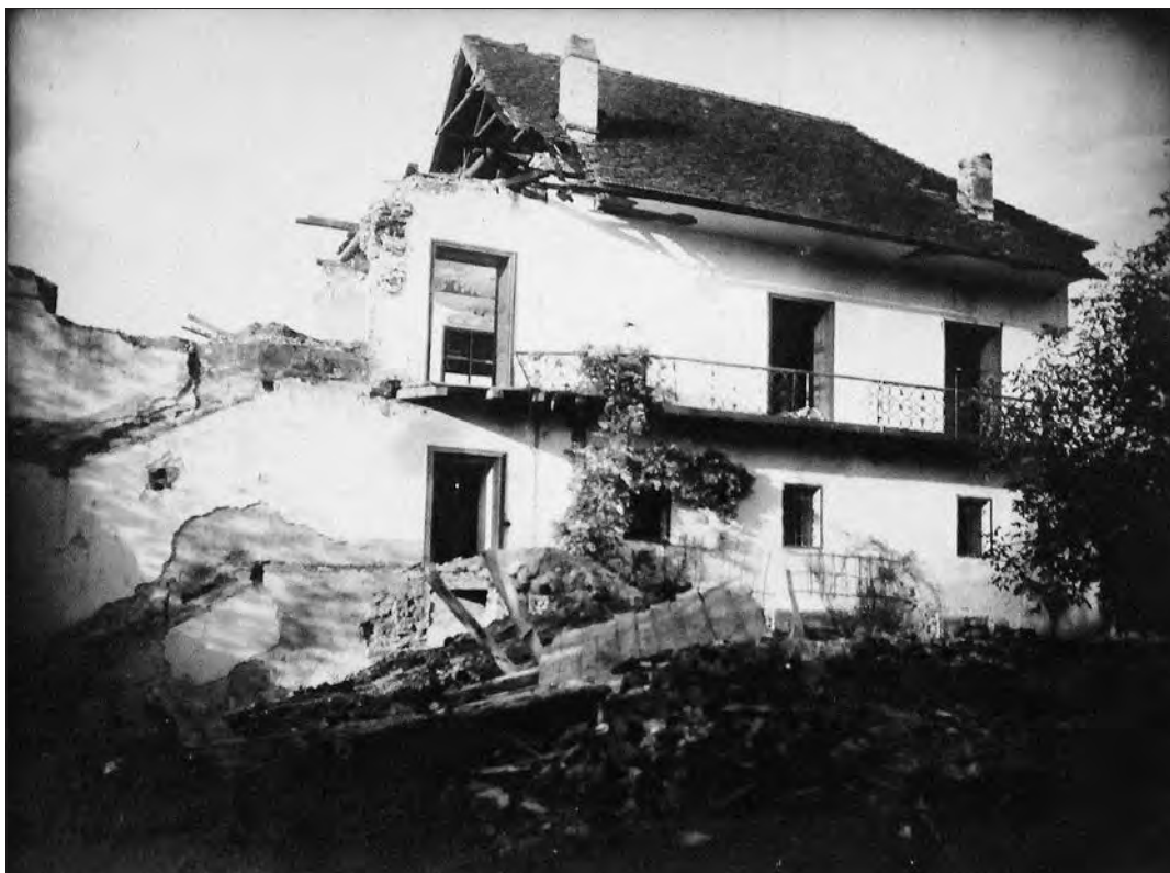
Pogled na v požaru poškodovani grad Branek z dvoriščne jugozahodne strani med podiranjem dvonadstropnega severozahodnega stranskega trakta pozno spomladi ali poleti 1926. Skozi vratno odprtino zgoraj levo so vidni ostanki baročnih štukatur v glavni grajski dvorani, na levi strani pa so vidni sledovi glavnega grajskega stopnišča, ki je povezovalo pritličje in obe nadstropji (foto: neznani avtor, PAM).
