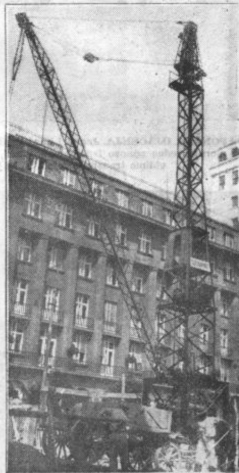
ŽELEZNA ROKA ZIDA. Ljubljanski prometni vozni pred pošto se je te dni prelevil. Na ozemlju podrtega »Slona« je pomolil v zrak železne krake velikanski žerjav, ki s vrhom seže skoro do ljubljanske kreditne banke. Ljudje se radovedni sprašujejo, kaj bo s to pošastjo pred pošto. Velike palače se so že gradile v osrčju Ljubljane, ali vse te zgradbe so zrastle po starih načinih zidanja s črti in dvigali ob njih. Pri gradnji novega hotela »Slona« pa bomo imeli priliko seznaniti se z novimi gradbenimi pripomočki. Najvidnejši med njimi je prav ta žerjav.
