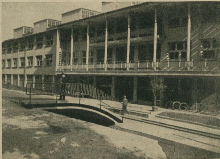
Pročelje upravnega poslopja Strojne tovarne v Trbovljah
