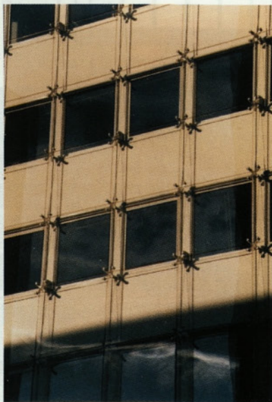
Slika 5: Fasada z dvema lupinama - IMP, Ljubljana, Dunajska cesta, [Schüco, Alukönigstahl]
