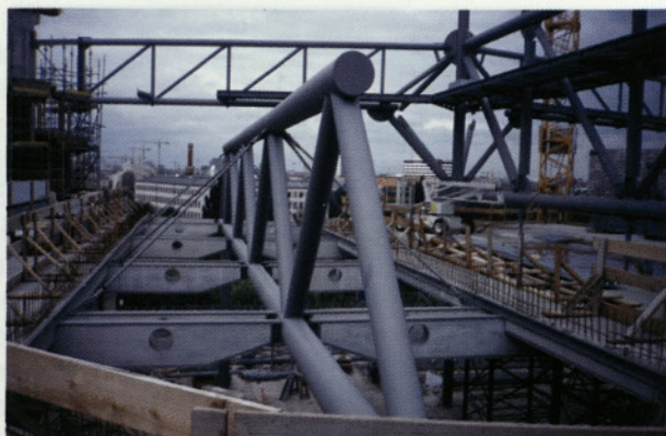
Slika 17: Stropni jekleni palični nosilec na katerega so spodaj priključene sovprežne grede, ki nosijo sovprežno AB ploščo (Muzej sodobne umetnosti v Berlinu)
