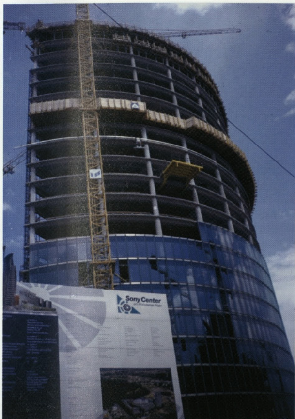
Slika 16: Izdelava steklene fasade na stolpnici Sony centra v Berlinu
