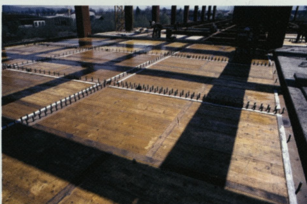
Slika 20: Pošta na Viču - opaženje sovprežne stropne plošče, vidni so jekleni moznički na gredah, ki zagotavljajo skupno delovanje AB plošče in jeklenih gred
