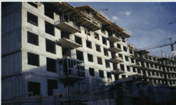
Slika 18: Stene z odprtinami (prečke so nosilni AB parapeti) stanovanjskega kompleksa Nove Poljane v Ljubljani
