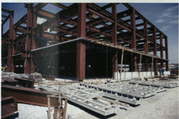
Slika 19: Jeklena okvirna konstrukcija pošte na Viču – vidni so dvojni stebri ob dilataciji
