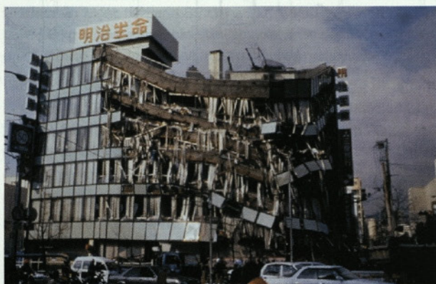
Slika 11: Rušitev stavbe z izrazito tlorisno asimetrijo (mehak vogal)
