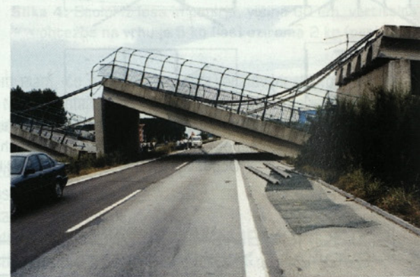
Slika 13: Zdrs prostoležeče mostne konstrukcije z ležišča
