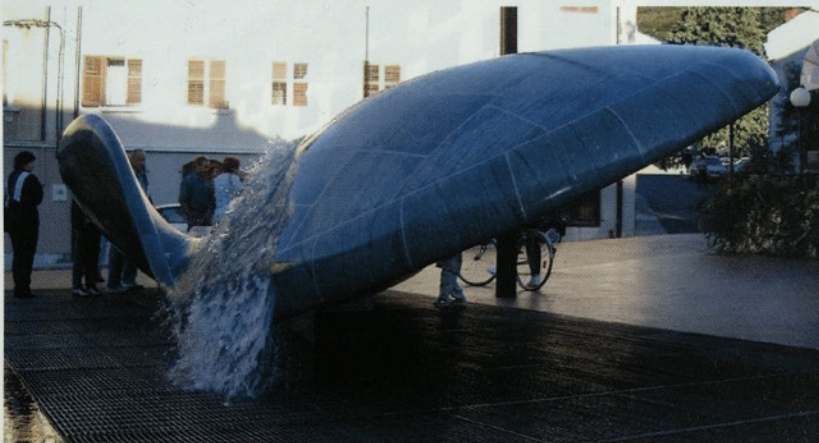
Slika 22: Lupina vodnjaka v Solkanu: ekscentrično podprta računalniško generirana forma obložena z marmorjem
