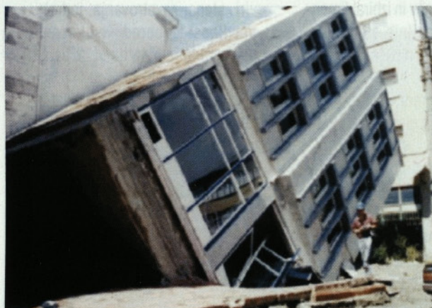
Slika 10: Posledice gradnje na neustreznih temeljnih tleh (likvefakcija tal)
