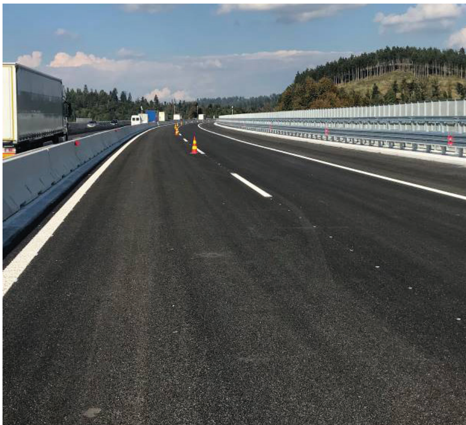
Slika 10 • AC na viadukih Ravbarkomanda po obnovi.
