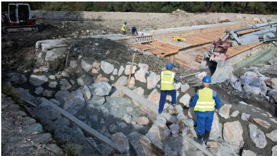
• Gradnja jezua na Savinji.
