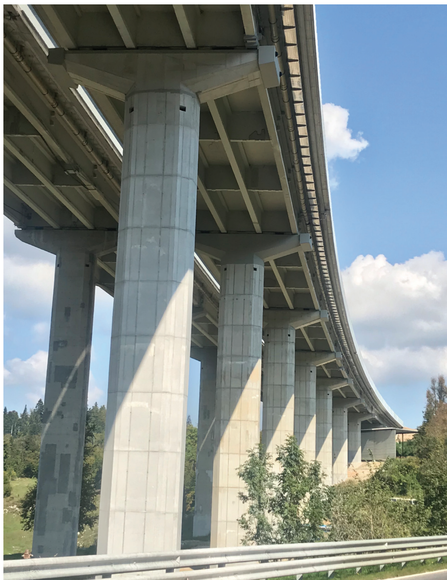
Slika 9 • Spodnja stran viaduktov Ravbarkomanda po obnovi.
