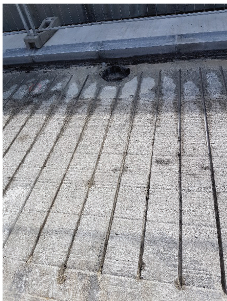
Slika 7 • Izrezkani utori v betonu nad armaturo.
