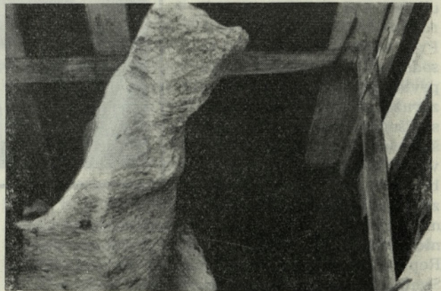
Sl. 10. V obliki stebra zakraseli apnenci povzročajo pogosto velike težave pri kopanju za temelje mostu. Na sliki je viden del temeljne jame za opornik viadukta na avtomobilski cesti pri Ponikvah
