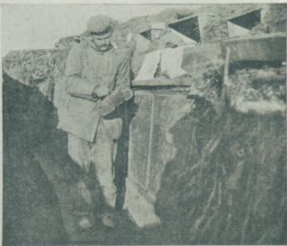
V nemškem strelnem jarku. Zgoraj se vidijo okenca, skozi katera mora vojak streljati, ne da bi dvignil glavo iz zakopa.
