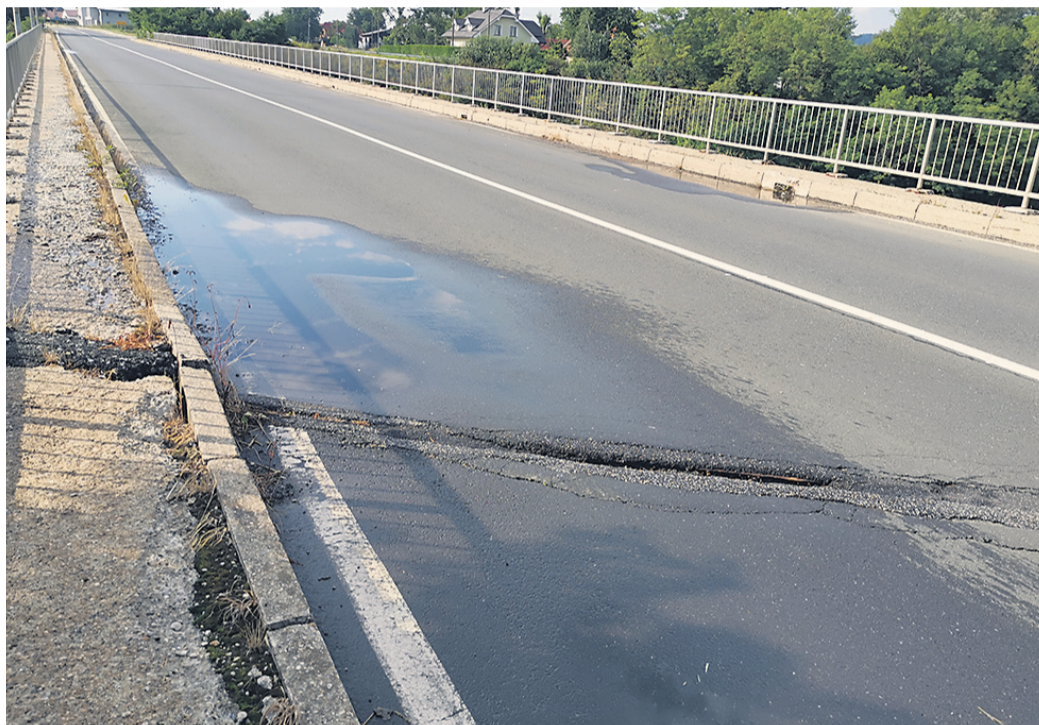
„Most je bil zgrajen v letu 1970, v letu 1992 pa so bila izvedena vzdrževalna dela,“ so navedli na Direkciji RS za infrastrukturo.
