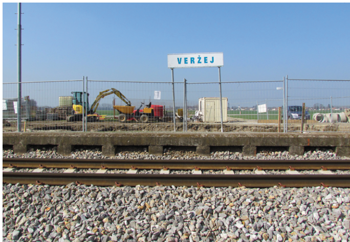
Gradbišče na lokaciji nekdanjega postajnega poslopja
