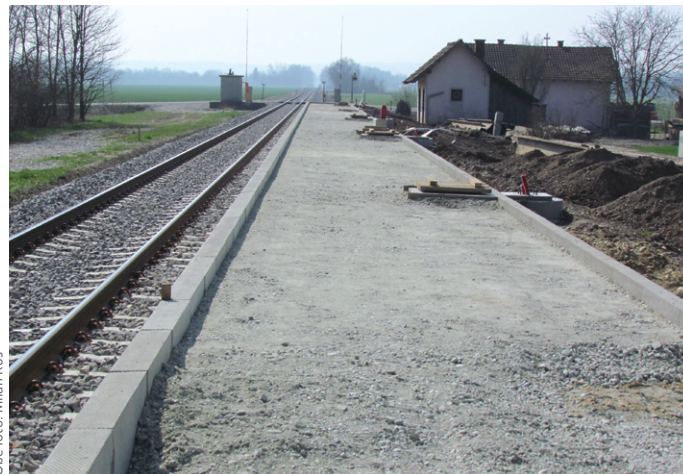
Novi peron v gradnji
