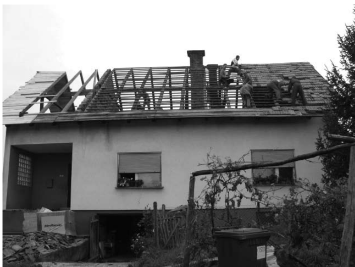
Streha pri Gregorečevih iz Placarja med obnovo
