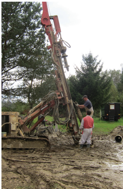
Vrtanje pilotov za točko
