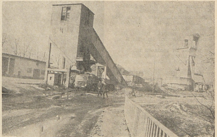
Obratne zgradbe z jaškom na obratu Kisovec v Zagorju
