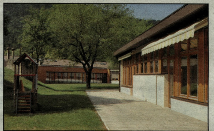
S prenovno in energetska sanacija starega dela se je zaključila celovita obnova vrtca
