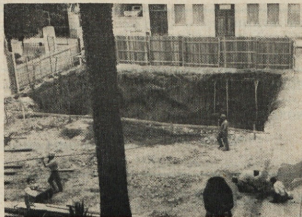
Fotografija kaže izkopani prostor za podkletitev in za temelje cerkve Marije Pomagaj v Buenos Airesu
