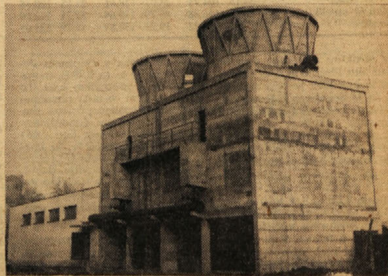
Hladilni stolp za industrijsko vodo v novem obratu za proizvodnjo žveplene kisline
