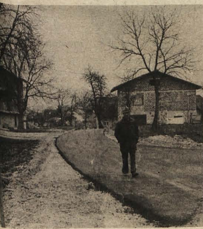
VEČ NOVIH ASFALTNIH KRAKOV — Nekateri šentjernejski ulice so pred kratkim dobile asfalt, nekatere ga pa še dobivajo. Vsega bo na novo asfaltiranih 5 km cest. (Foto: R. Bačer)
