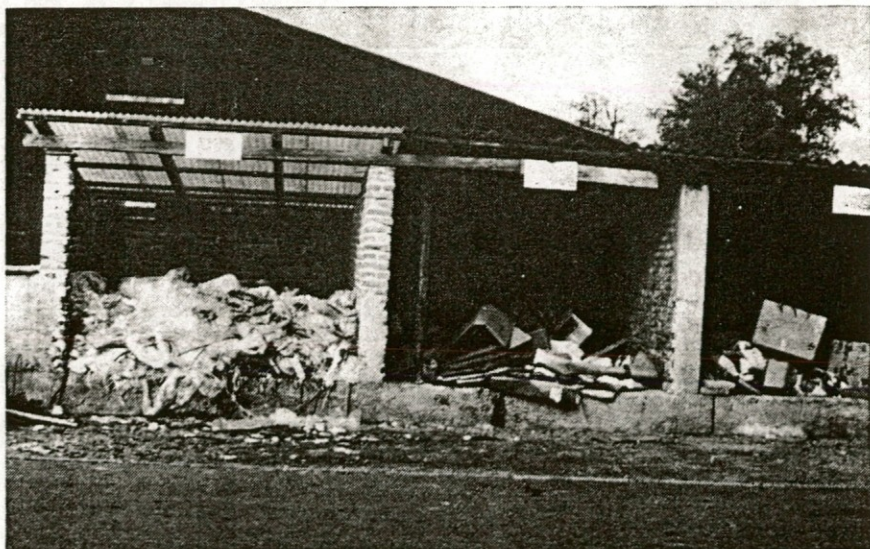
Urejeno odlagališče, kjer se odpadni materiali sortirajo
