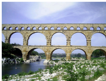
Rimski vodovod, oskrbuječ mesto. Preko reke je speljan po obočnatem mostu. Pont du Gard, Francija, 100 let pr. n. št.
