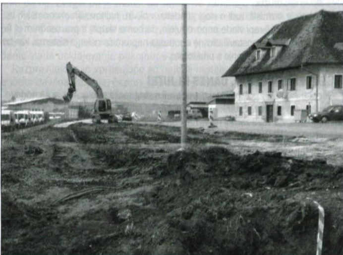
Pri tovarni Motvoz in platno je zasebno podjetje kopalo jarke za telekomunikacijske kable in potrebne jaške.
