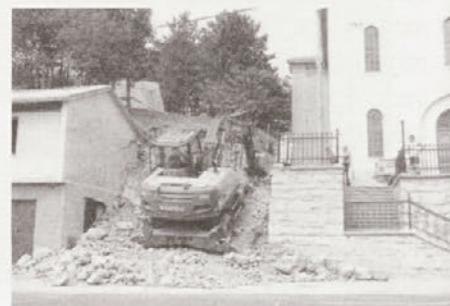
Začetek izgradnje nove garaže ob cerkvi leta 2004.
