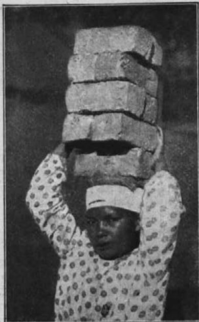
Prostovoljna pomoč pri zidavi misijonske cerkvice.
