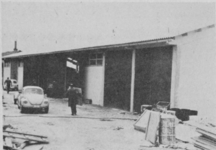
Zaključna dela na prvi proizvodni dvorani
