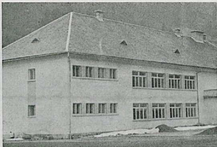
Sl. 15. Poslopje osemletke v Zeleznikih, pokrito s strešnimi ploščicami iz spodnjejurskega strešnega skrilavca izpod Greblovega vrha Foto A. Ramovš
