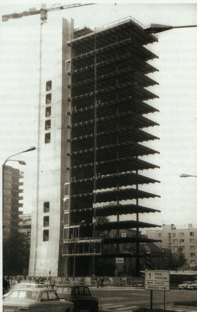
Slika 9 • Poslovna zgradba Bavarski dvor med gradnjo
