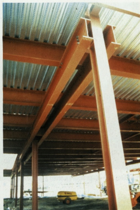
Slika 25 • Primer uporabe »parallel beam approach«-a
