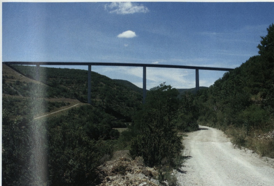
Slika 2 • Pogled na viadukt Verrieres
