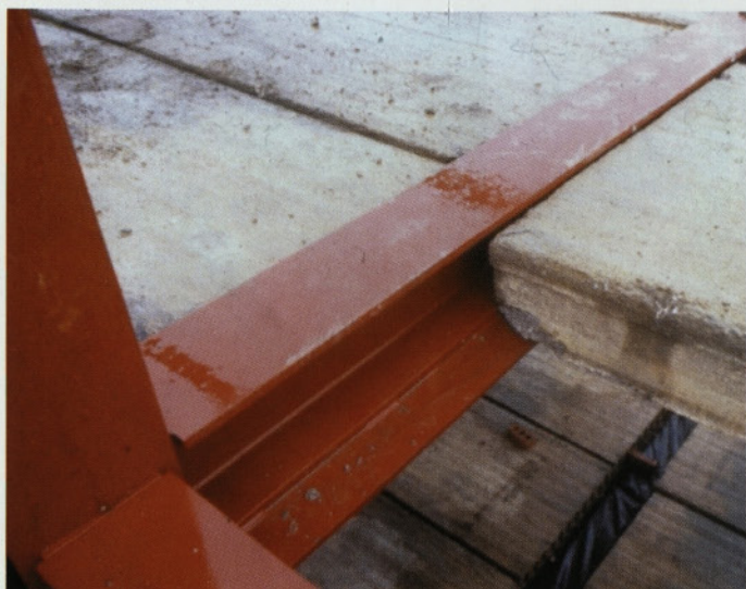
Slika 26 • »Slim floor« sistem z montažnimi ploščami
