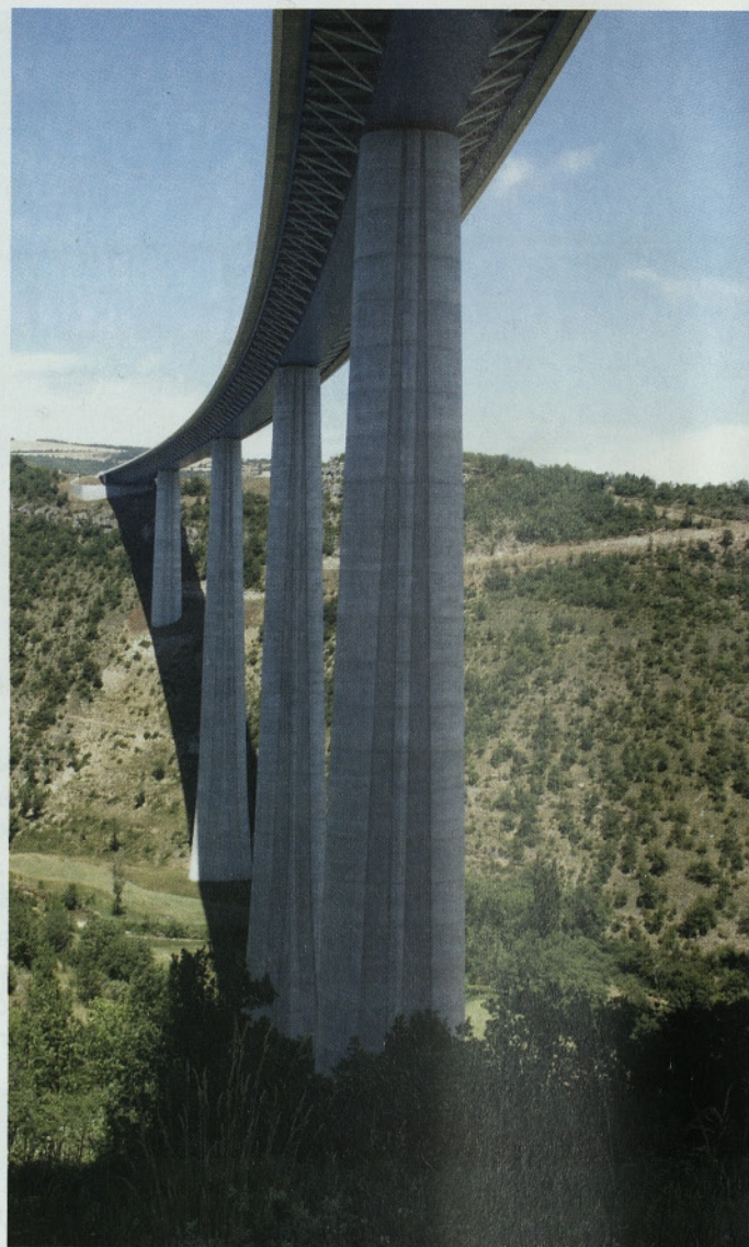
Slika 5 • Vzdolžni pogled na viadukt Verrieres od spodaj
