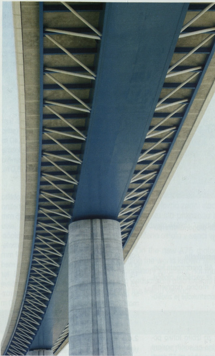
Slika 4 • Pogled na prekladno konstrukcijo viadukta Verrieres
